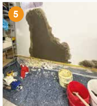
Einfüllstück vom Injektionspacker entfernen und Fläche mit einer sulfatbeständigen, mineralischen Dichtungsschlämme abdichten.
