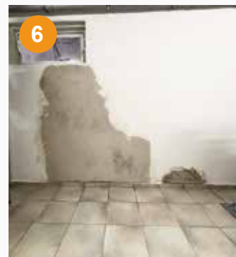
Abgedichtete Fläche der restlichen Wandfläche angleichen, sodass die Wandfläche wieder genau so aussieht, wie der restliche Bereich.
