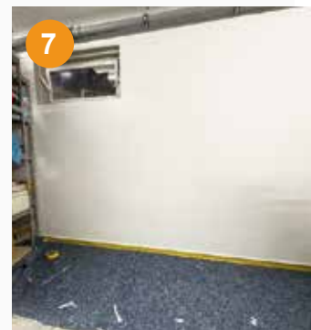
Die Wandfläche wird abschließend gestrichen.
