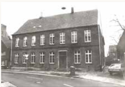
↑ Bild 2: Ehemalige Schule an der Münsterstraße, im Hintergrund das Schulgebäude am Südwall
