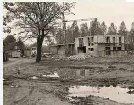
↑Bild 6: Der Rohbau des damals neuen Feuerwehrgerätehauses am Sandplatz im Jahr 1964
