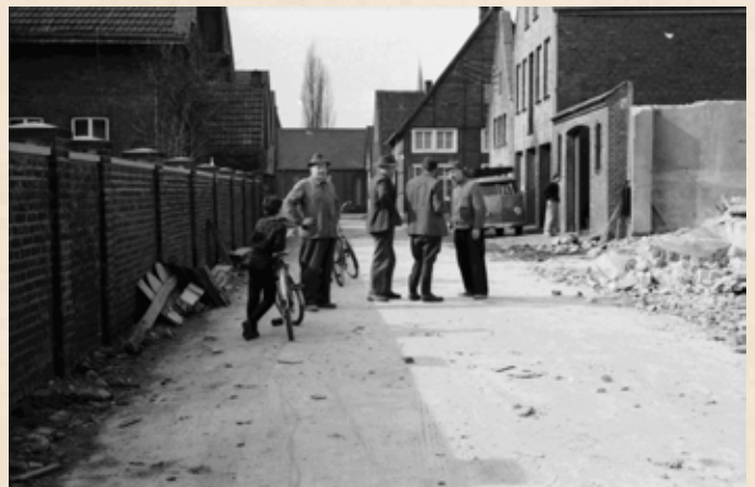
↑ Blick in den „verkehrsarmen“ Kühl (Gebäude am Ende der Straße: Scheune Schulze Röttering)
