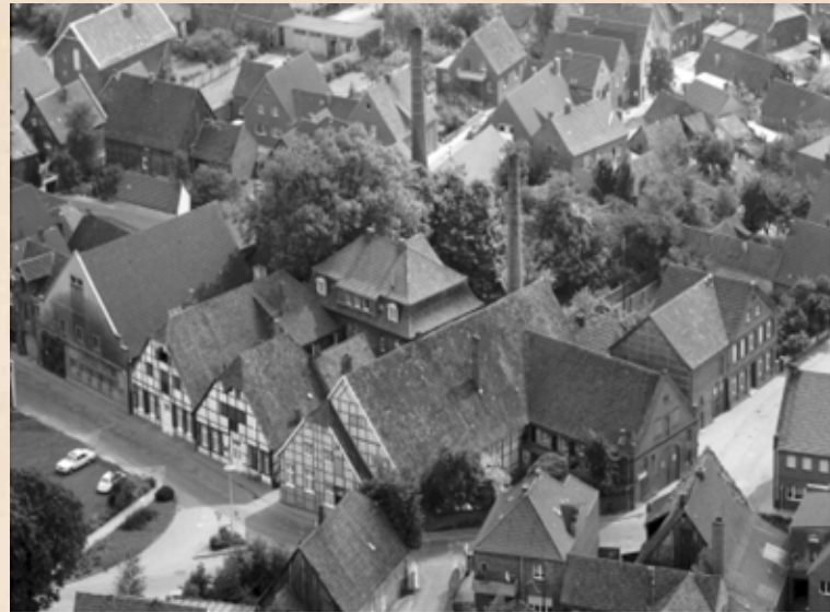
↑ Luftaufnahme, Ende der 1960er Jahre, „Eingang“ zur heutigen Fußgängerzone (Einweihung 1988) mit den Brennereien Graute und Schulze Rötering (Gassner). Das Ensemble mit den Fachwerkhäusern Graute, Löwenstein, Gaßner auf der rechten Seite Richtung Osten ist erhalten geblieben.
