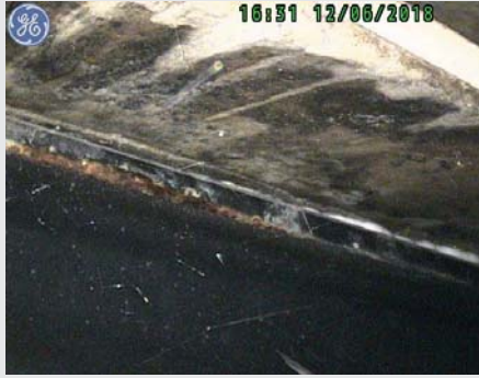
↑ Wasseraustritt unterhalb einer Duschtasse (nach 6 Monaten)
