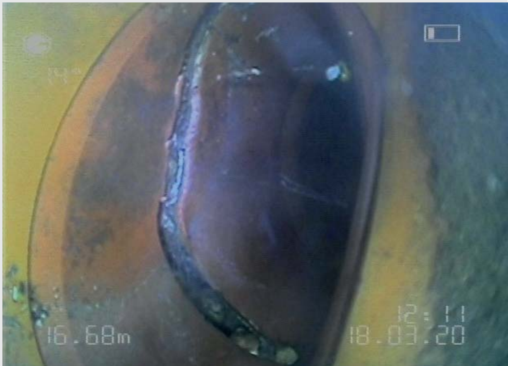
↑ Bruchstellen innerhalb der Entwässerungsleitung, hier eine Bruchstelle im KG-Rohr
