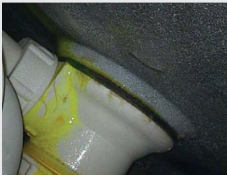
↑ Endoskopische Untersuchung unterhalb einer Duschtasse mit Färbemittel
