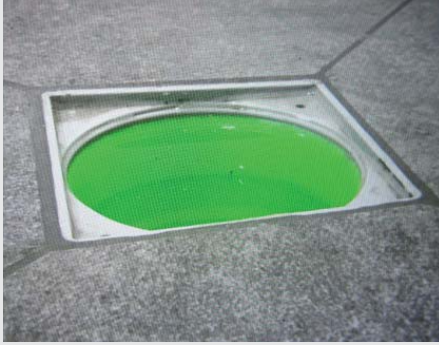
↑ Untersuchung eines Bodenablaufes einer bodentiefen Dusche
