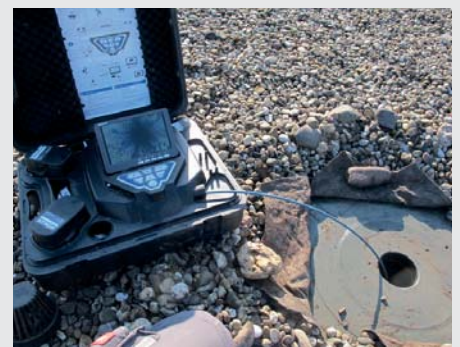
↑ Kamerauntersuchung eines Bodenablaufes im Flachdachbereich
