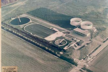
↑ neue Kläranlage nach Fertigstellung (Bau 1980–83)
