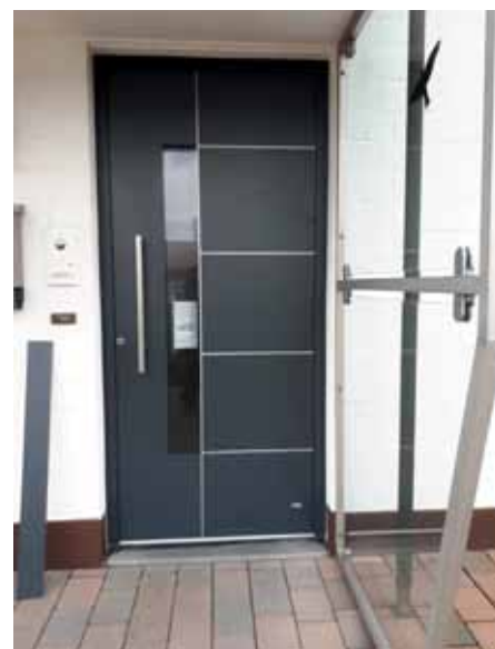
NEUE TÜR NACH EINBAU
