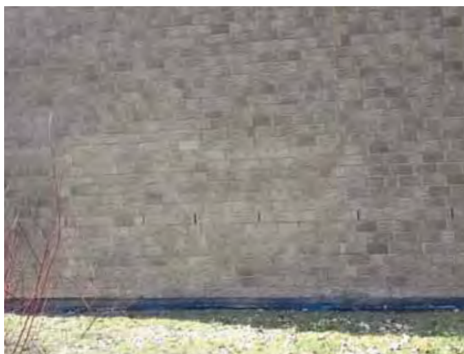
WAND NACH FACHMÄNNISCHER ENTFERNUNG DURCH DEN MALERFACHBETRIEB DESCHER
