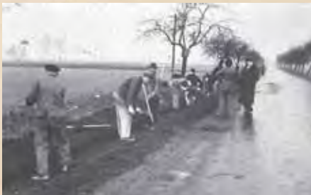
1949: BAU DER WASSERLEITUNG VON DER HARDT IN DIE STADT
